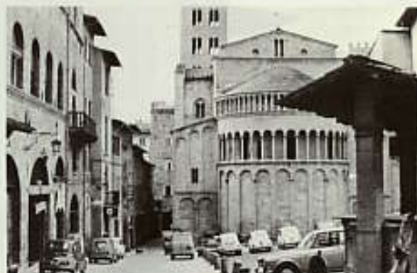
グランア広場の敷石, Pavement of Piazza Grande
